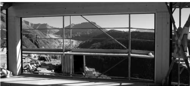
03.10.2011 – Blick vom Panoramasaal Richtung Aletschgletscher im auskragenden Teil.
