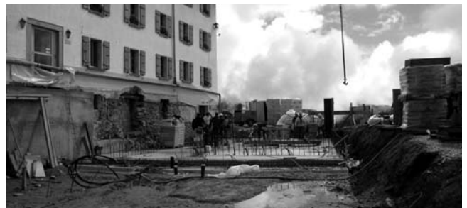
18.07.2011 – Die Betonbodenplatte des östlichsten Teils ist gegossen. Der nächste Teil wird vorbereitet.
