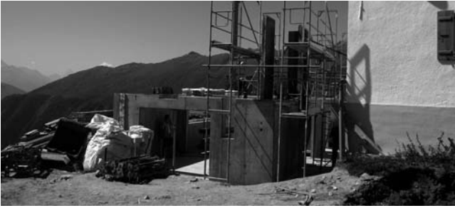
22.08.2011 – Blick vom Aletschbord: Die Betonstützen im Erdgeschoss werden geschalt.
