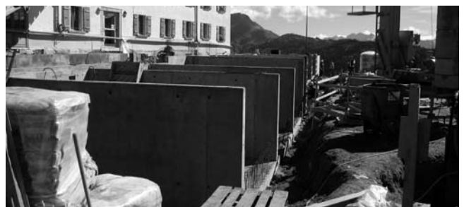
15.08.2011 – Die Betonwände im Untergeschoss sind bereits fertiggestellt.
