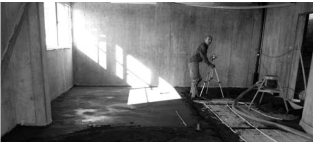
26.09.2011 – Die Garage im Untergeschoss: Der Zementunterlagsboden wird gegossen.
