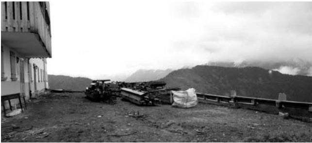
07.06.2011 – Die alte Sonnenterrasse ist demontiert und liegt aufgestapelt auf einer Holzbeige.
