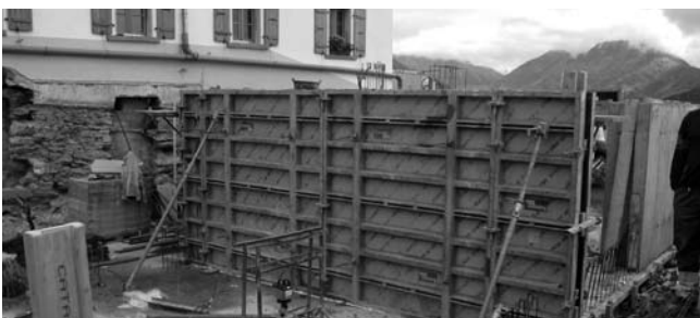
25.07.2011 – Die ersten Wandschalungen des Untergeschosses werden aufgestellt.
