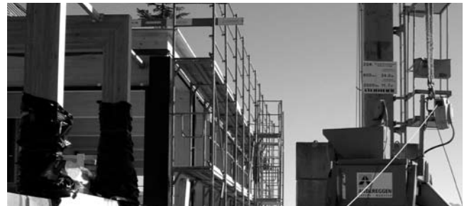
03.10.2011 – Links: die Joche der Sonnenterrasse – Rechts: Die Metallrahmen des Panoramasaals werden montiert.
