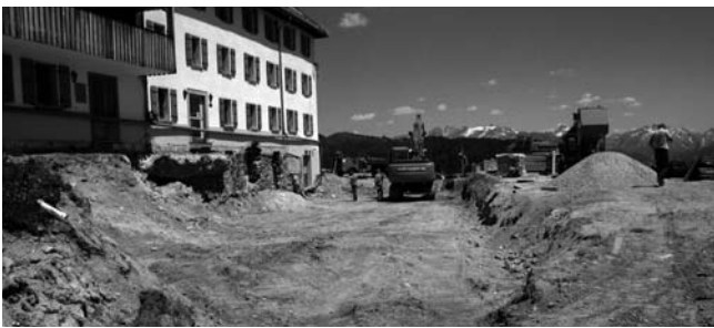
28.06.2011 – Der Erdaushub des Ostteils ist bereits abgeschlossen. Der Altbau ist noch nicht unterfangen.
