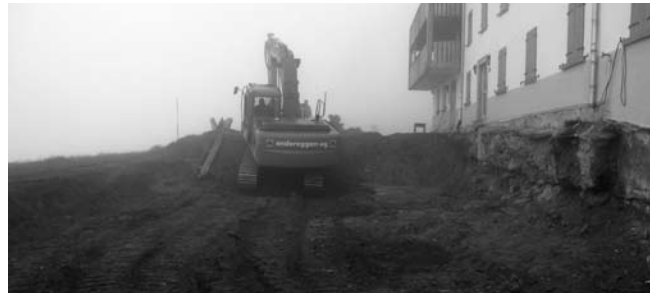
13.06.2011 – Die Aushubarbeiten sind in vollem Gange.
