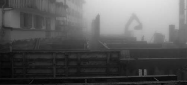
05.09.2011 – Die Wände der Sonnenterrassen-Unterkonstruktion werden betoniert.
