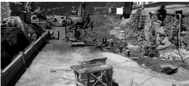
11.07.2011 – Der Magerbeton unter der Betonbodenplatte wird vorbereitet. Die Bodenplattenschalung ist aufgestellt.
