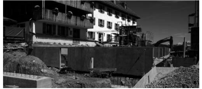
29.08.2011 – Die Fundamente der Sonnenterrasse im Westteil werden erstellt.
