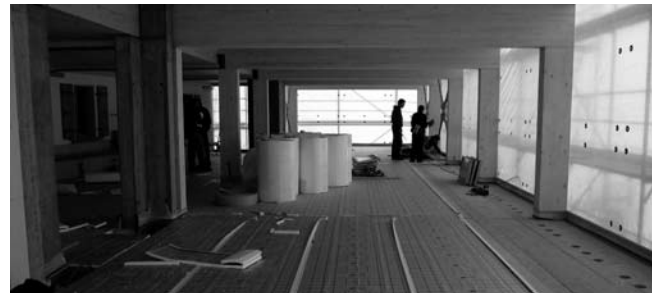
19.09.2011 – Der Panoramasaal von innen: Die Wärme- und Trittschuldämmung wird verlegt.
